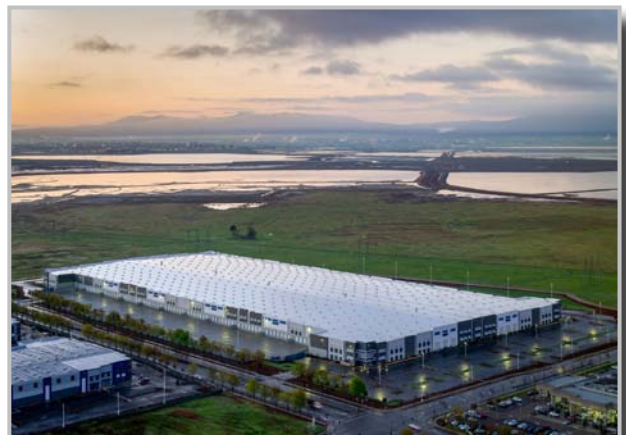
Pacific Commons South UPS
